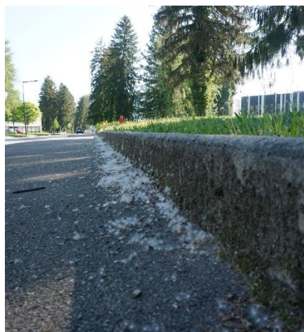
Photo 2 : Trottoir à bordure haute ©A. Aubry
